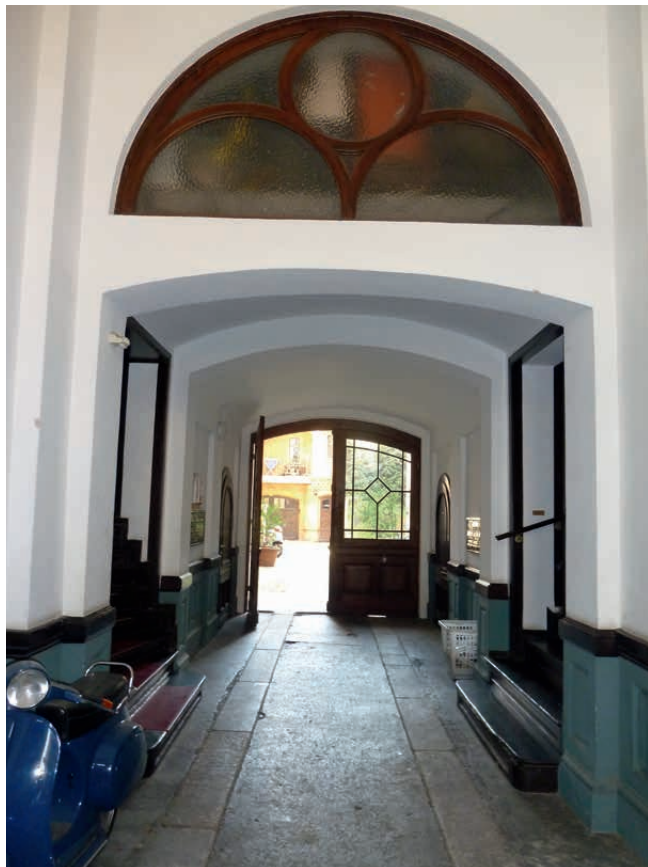
Hofdurchgang des Mehrfamilienhauses Kardinal-Albrecht-Straße 41 in Halle an der Saale aus 1907 mit 13 Wohneinheiten
