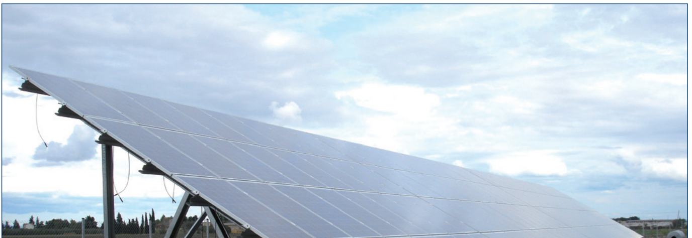
Apulien bietet selbst im November noch gute Voraussetzungen für den Betrieb der Anlagen.
