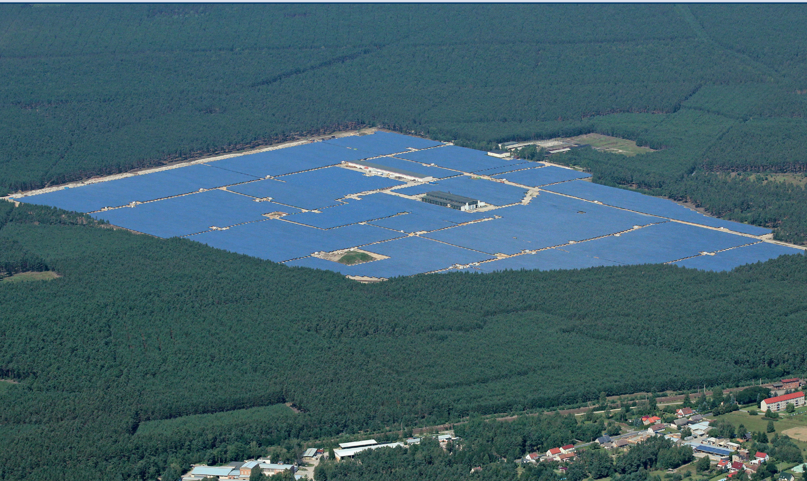
Der Enerparc Solarpark Walddrehna ist bereits seit Mitte 2012 in Betrieb.
