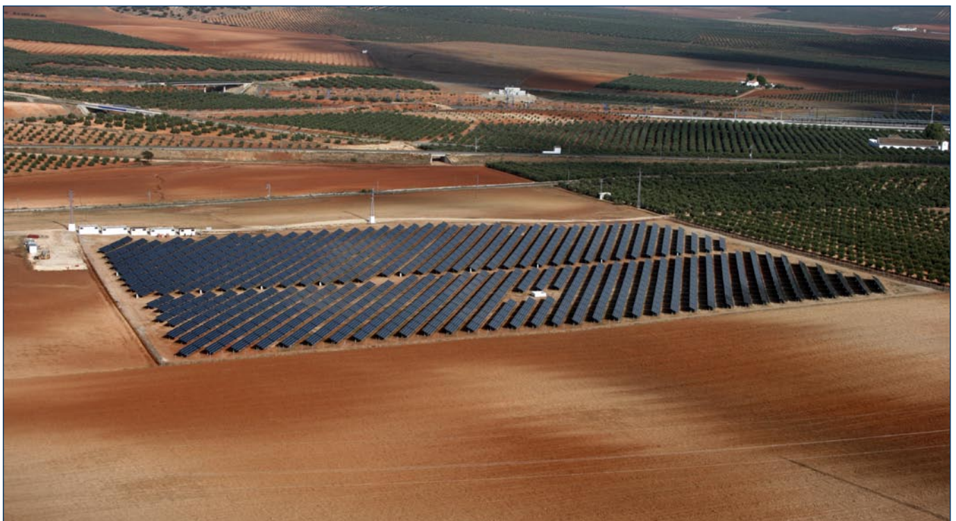
Solaranlage Antequera (Quelle: SolEs)
