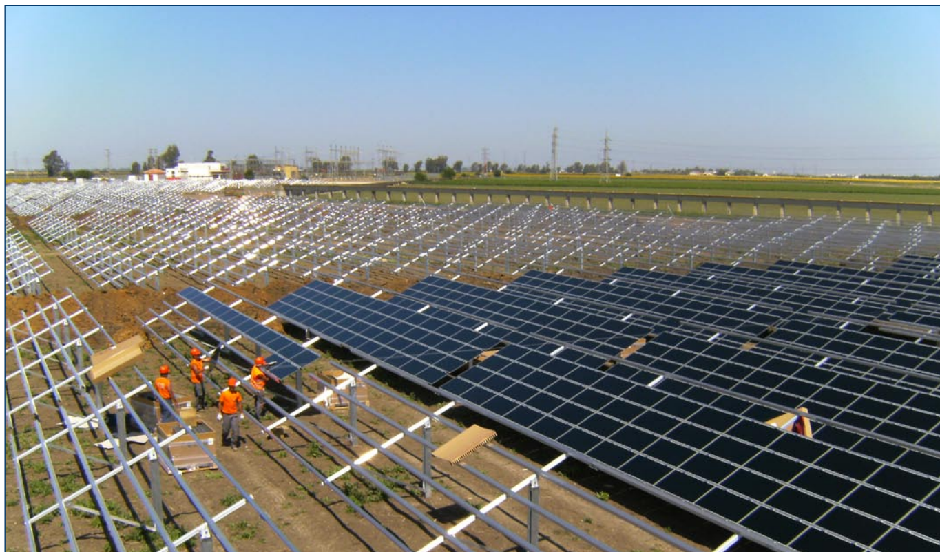
Die Anlage in Los Palacios, hier im Bau, liefert seit 2008 Strom (Quelle: SolEs)
