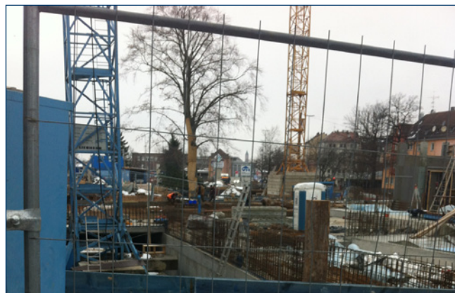
Die Baustelle auf dem FrankenCampus (Quelle: Unternehmen)
