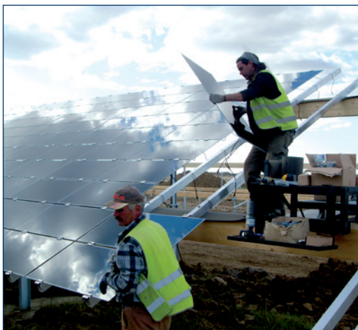
Auflegen der Solarmodule beim Neubau der Anlage in der südwestspanischen Region Extremadura
