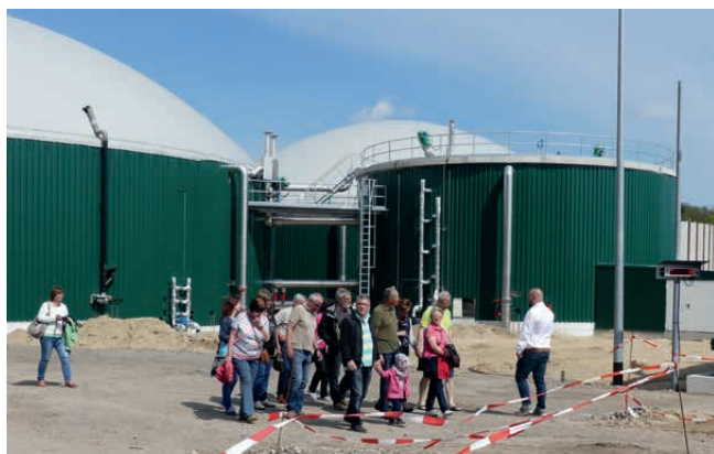
Besichtigung in einer Biogasanlage.
